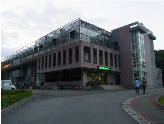
写真1. 二階建物の上に設置された実験温室.
