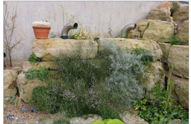
図6 通風口から地下を通して風を送るパイプ。
