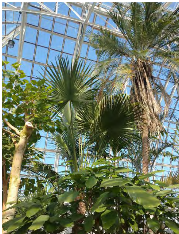
植栽工事が完了した中央ヤシ室。
