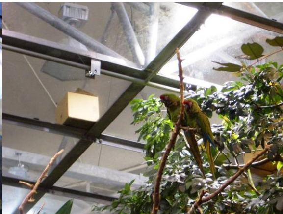
熱帯雨林の部屋の天井・ガラスが内張りされている。
