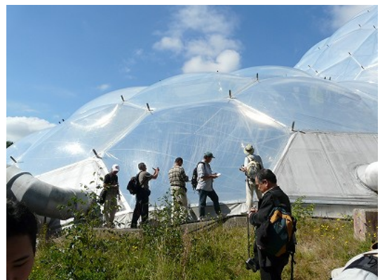
写真 2. 温室バイオームの被覆材 ETFE の視察
