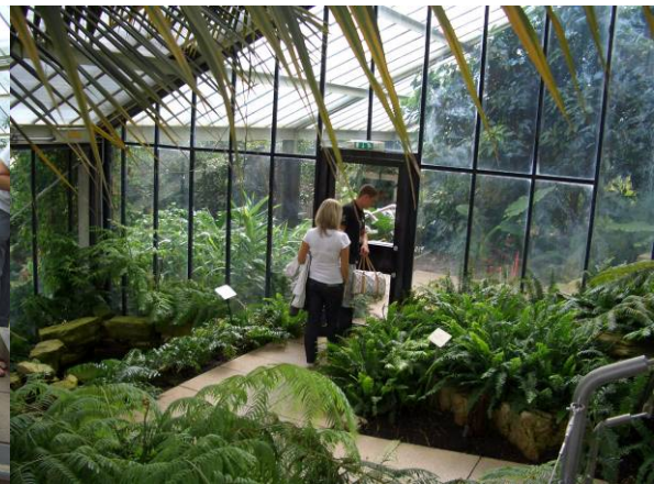
気候環境が異なる部屋の間には間仕切りがある。
