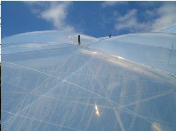
継ぎ目の線で三枚のフィルムで構成されていることがわかる
