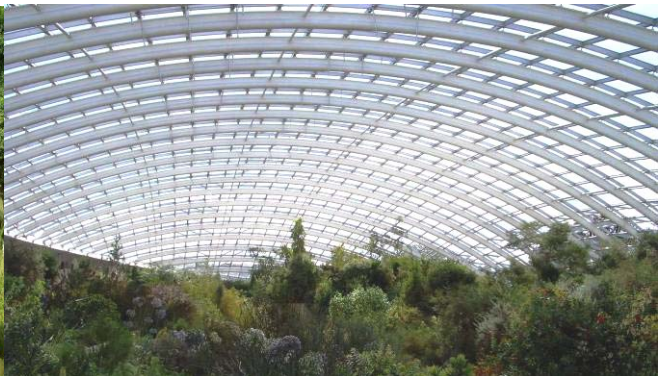
温室内部空間
