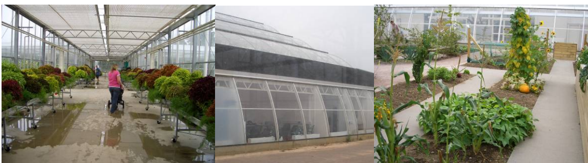
温室に続くバックヤードの通路（奥は栽培温室）
