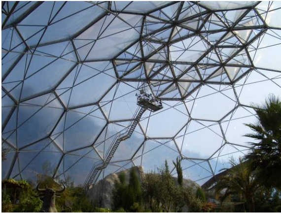
六角形の枠を鋼棒のトラスで支えている。(天窗付近)
