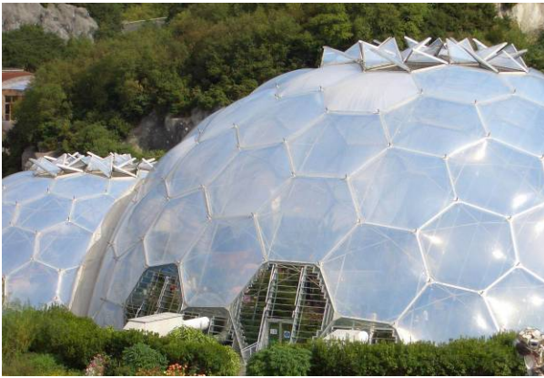
換気システム：下部から吸気し、天窗から排気する自然循環。
